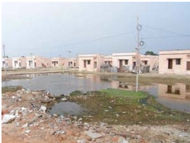
En av betongbyarna som regeringen byggt upp
